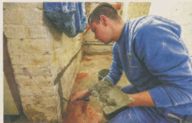
Tommy Uhlig ist mit seinem Vater Sven im Einsatz. Nachdem die Elektroden verbaut wurden, wird verputzt. FOTO: YON SÖLL
