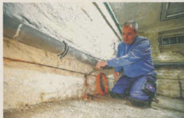
Monteur Sven Uhlig von Drymat beim Verbaue der Anode ins Mauerwerk. FOTO: YON SÖLL
